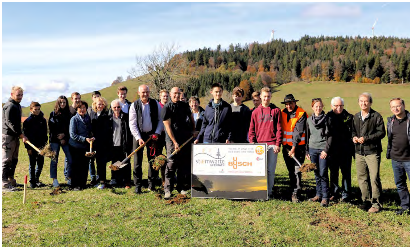
Ende Oktober fand der Spatenstich für die „Sternwarte Gersbach“ des Schülerforschungszentrums Lörrach-Dreiländereck statt. (Foto: SFZ Lörrach-Dreiländereck)
